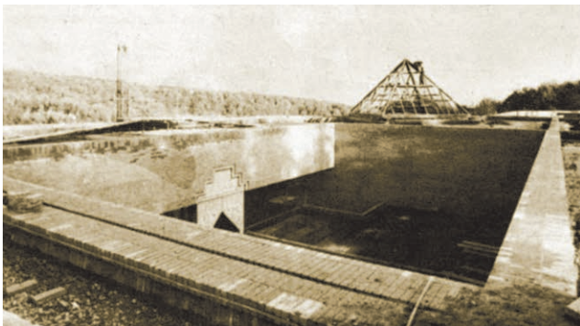
Detalj krovništva tijekom građenja
