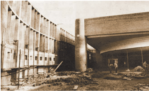
Gradnja glavnog ulaza
